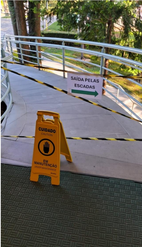
Troca de pedras danificadas na passarela de acesso ao Ginásio
