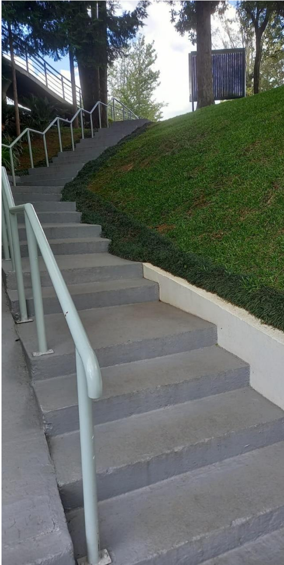
Pintura Escada e Corrimão
