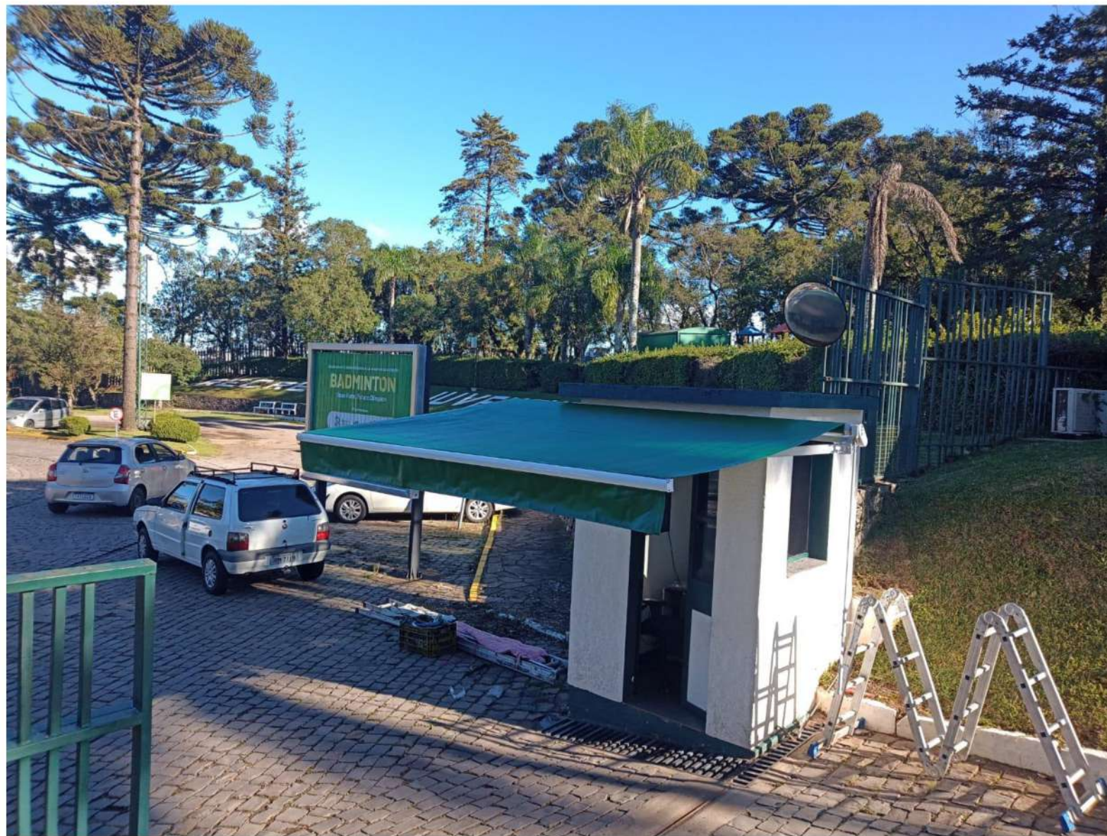
Instalação de um novo toldo na Portaria Principal da Sede Juventude
