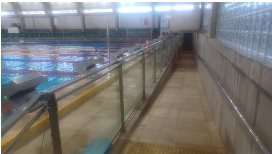
Rampa de Acessibilidade ao local de treinamento.
