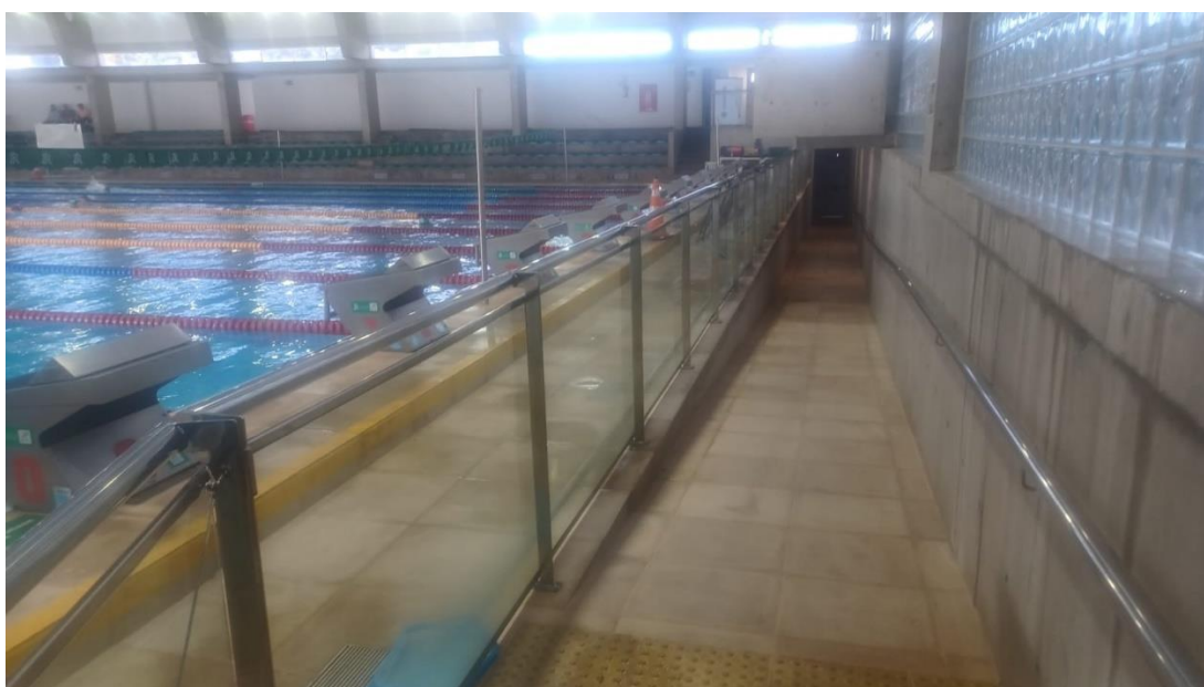
Imagem 4 - Rampa de Acessibilidade ao local de treinamento.
